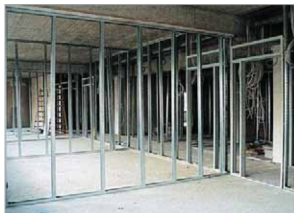
Монтаж профиля для внутренних перегородок
